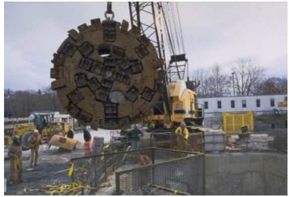
Ejemplo de cabezal de corte de una tuneladora
