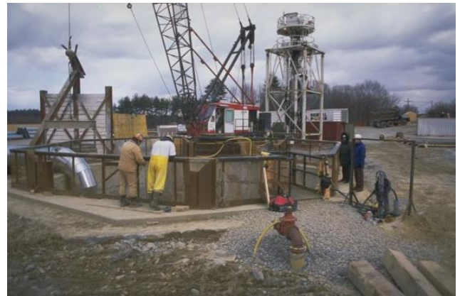
Ejemplo de tareas de construcción en los pozos
