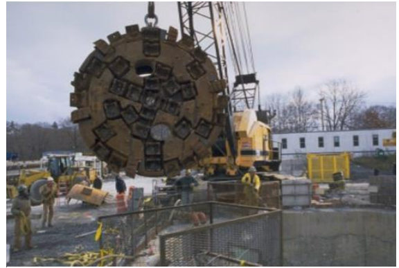
隧道掘进机切割头示例
