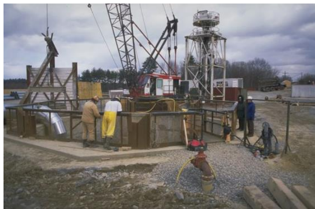
竖井施工活动示例
