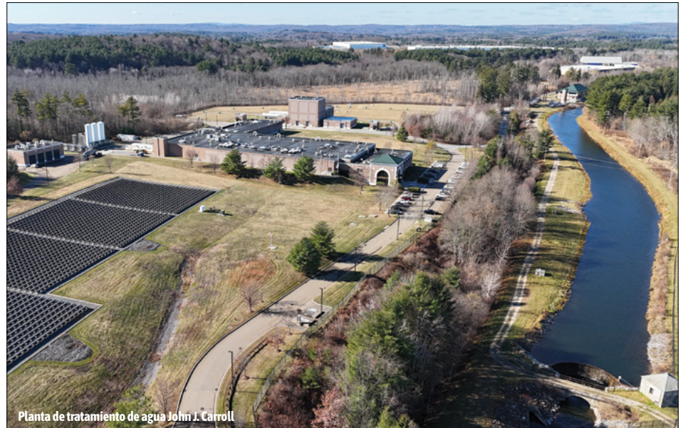
Planta de tratamiento de agua John J. Carroll
