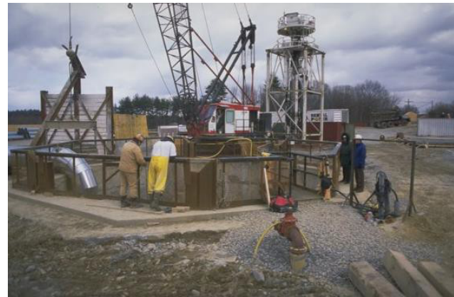
竖井施工活动示例
