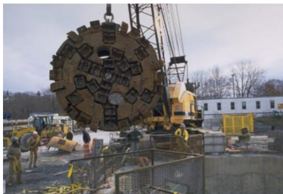
隧道掘进机切割头示例
