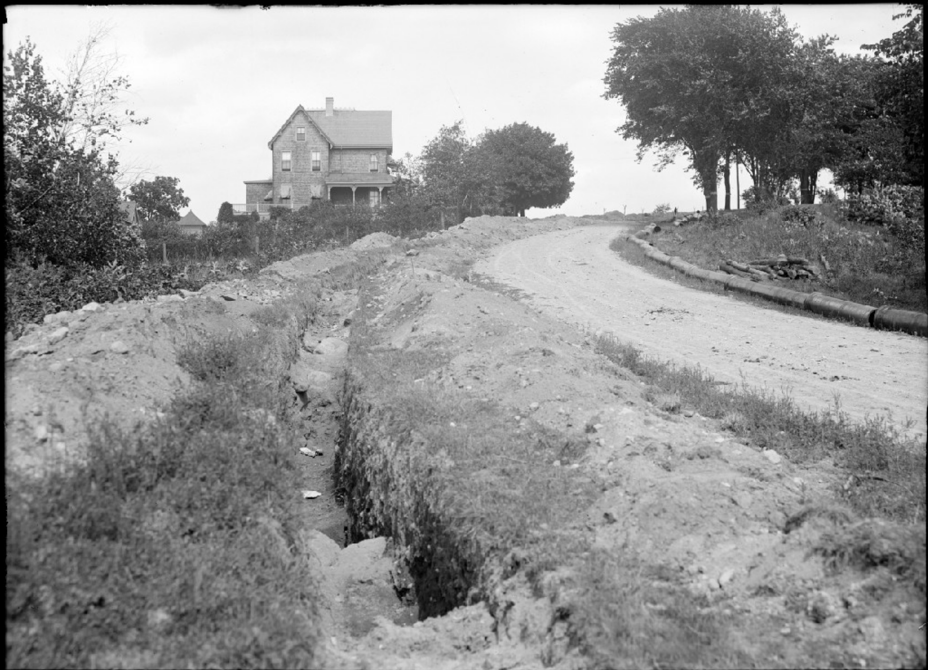
12 IN. N. EX. H. S. PIPE LINE PARK AVE, ARLINGTON. SEPT. 1, '09
